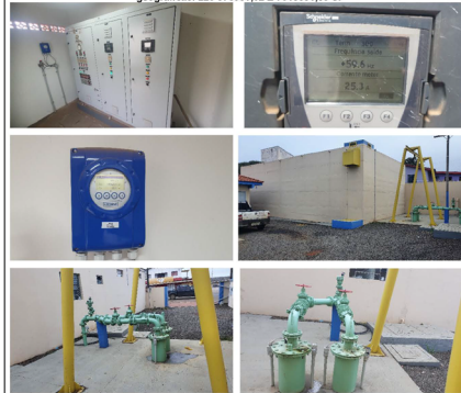
Figura 4 - Imagens do Reservatório Principal da Sede do Município de Ventania. Coordenadas geográficas: 22J 576951,02 E 7318556,80 S.
