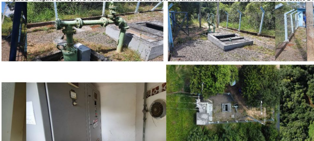
Figura 2 - Imagens do Poço n°2 localizado na Sede do Município de Ventania. Coordenadas geográficas: 22J 581298,68 E 7
